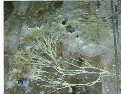
infestation est constatée il faut faire des sondages et mises à nu y compris dans le périmètre de sécurité, remplacer ou renforcer les éléments dégradés, supprimer l'infestation et ses causes, remettre en état :
